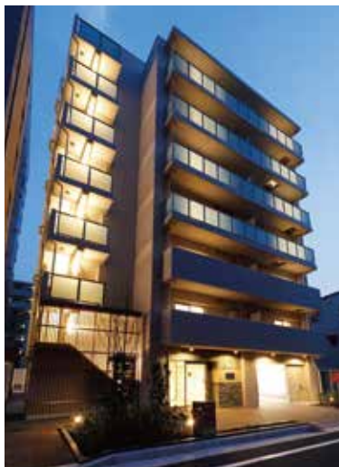
北東側外観(夕景)
